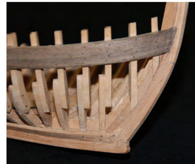
Photo n. 22: couples dévoyés et courbe des préceintes. Une fois le montage des couples terminé il est préférable de fixer tout de suite les préceintes de chaque côté, de façon à bloquer l'ensemble de la structure. Ensuite on passe à fixer le galbord et le ribord Enfin on arrivera à la carlingue, celle-ci est composée de 3 pièces: celle du centre emplanture pour le pied du mât.
