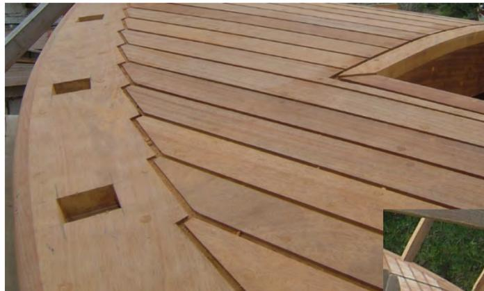
Photo n° 77b: Quelques montants montés en place. Cette opération sert à donner la correcte courbure au vibord et pour finir de placer les derniers montants.
