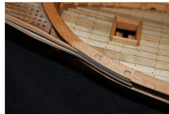
Photo n° 121: Vue latérale de la poupe. Les deux ouvertures rectangulaires logeront les deux montants verticaux
